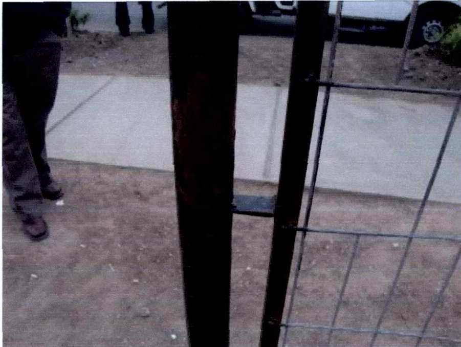
Fotografía 3: Perfiles metálicos sin lijar.
