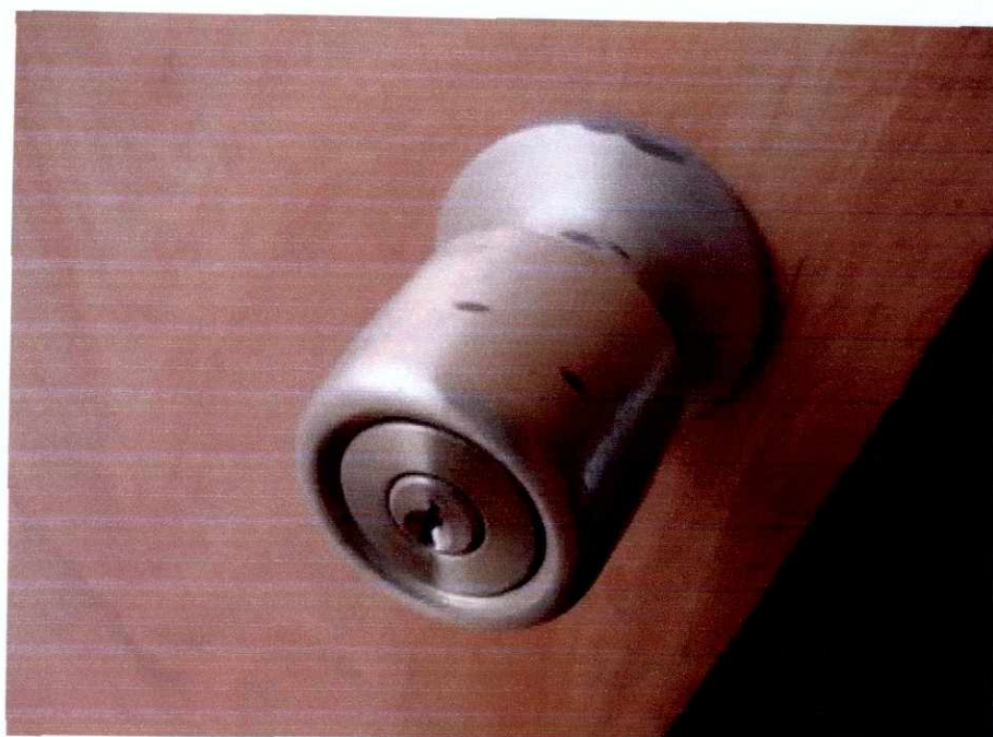
Fotografía 8: Cerradura corroída
