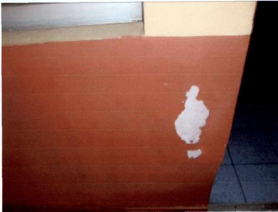
Fotografía 11: Pintura descascarada.
